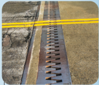
Слика 5.2.2: Разлика у дужини бетонског моста од неколико стотина метара лети и зими је неколико десетина центиметара.
