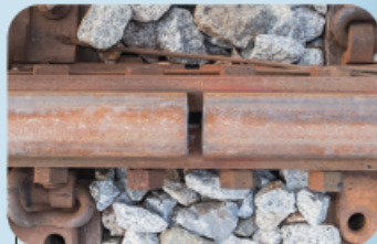
Слика 5.2.3: Процеп између железничких шина који дозвољава промену њихових дужина на различитим температурама.
