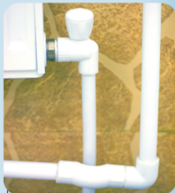
Слика 5.2.4: Спојеви повезују цеви код централног грејања, јер кроз њих пролази топла вода.
